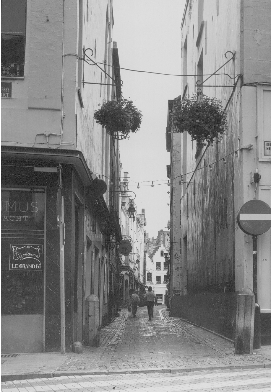
Figure 3 : Zone piétonne de l'îlot sacré, accessible le matin pour les livraisons. Source : Petite rue des Bouchers, Bruxelles, 1980. © KIK-IRPA, Bruxelles.
