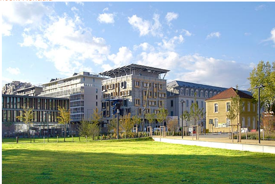
La caserne de Bonne, Grenoble. Source : Ville de Grenoble.
