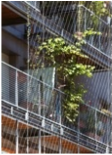
Figure 3b : Situation de la façade végétalisée sur les balcons du bâtiment A. Source : Renault, 2012.
