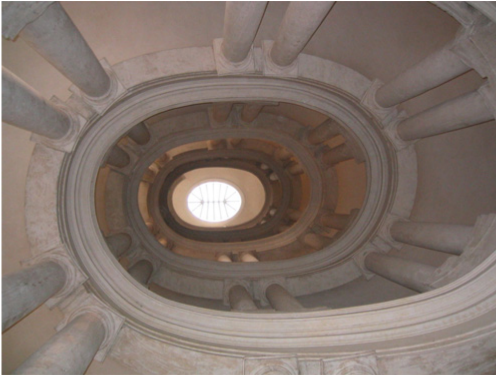
Escaliers intérieurs, Palais Barberini, Rome.
