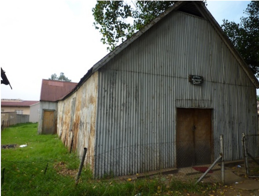
Figure 1. « Quand je revois ma p'tite église... ». L'église méthodiste de Comet, seule des trois églises encore en place et utilisée. Construite en tôle ondulée et située près de l'entrée de la cité (Gervais-Lambony, 2011).
