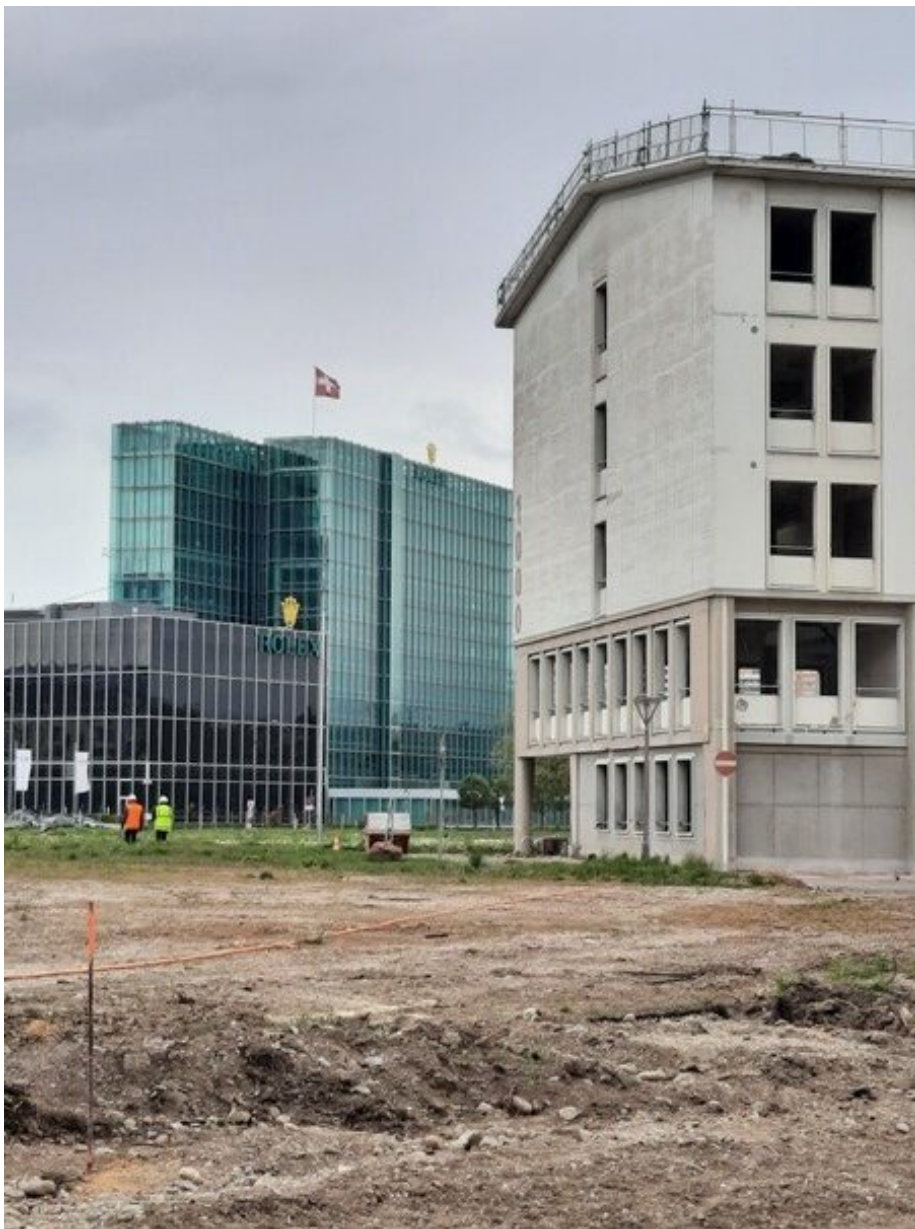
Figure 7 : Photo des auteurs, avril 2021.
