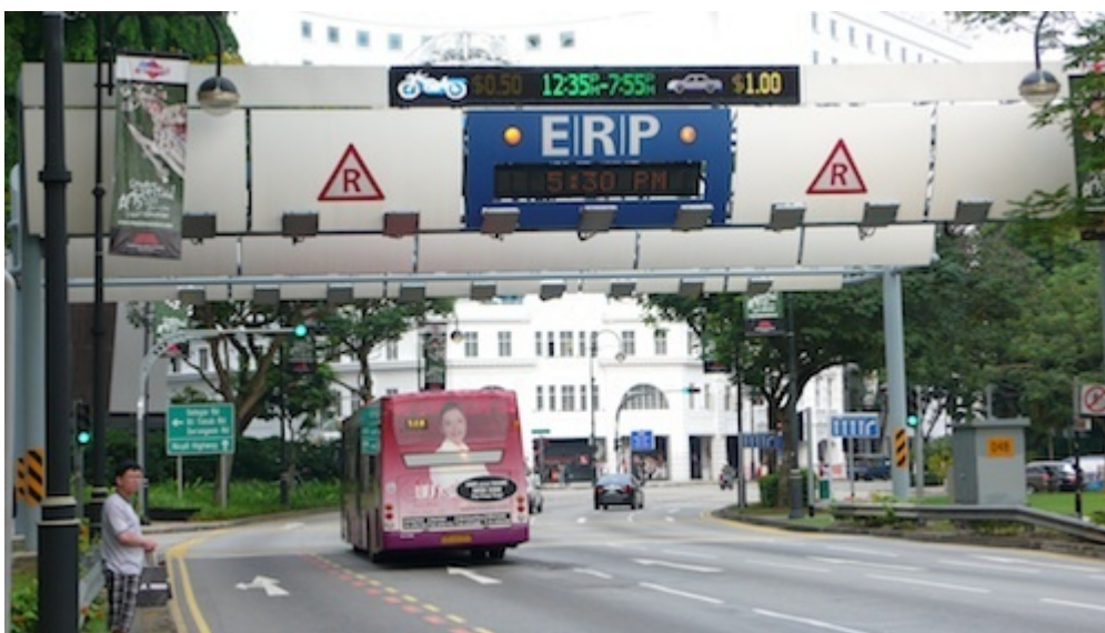
Photo 2 : portique de télépéage à Singapour © J.-Ch. Gay, 2011.
